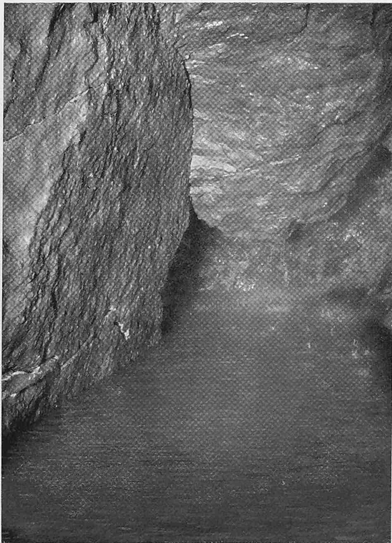
Abb. 12. Blick vom Tunnel gegen F .
