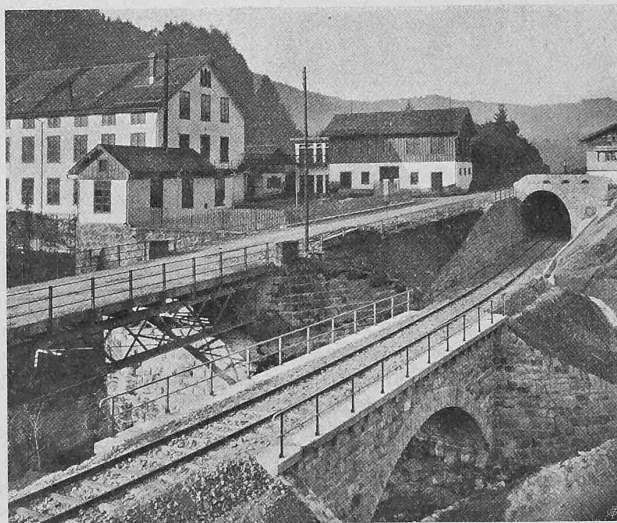
Abb. 5. Brücke über den Lütisbach und Trempel-Tunnel.
