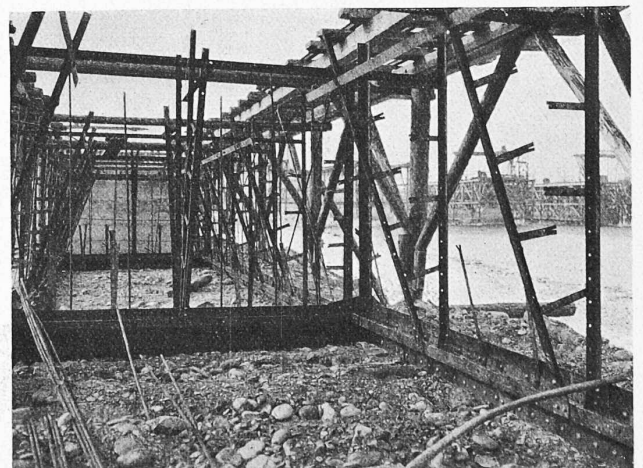
Abb. 76. Montage der Betoncaisson-Armierung (Januar 1909).
