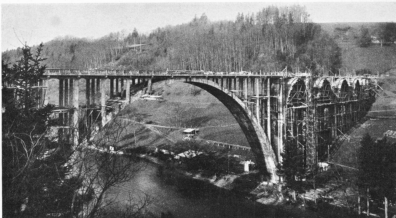
Abb. 5. Blick auf die Halenbrücke im Bau, vom linken Hochbord der Aare (Aufnahme von H. Völlger in Bern).
