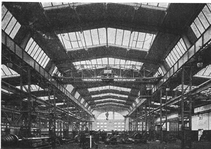
Werkstätten Eisenwerk Wülfel bei Hannover.
