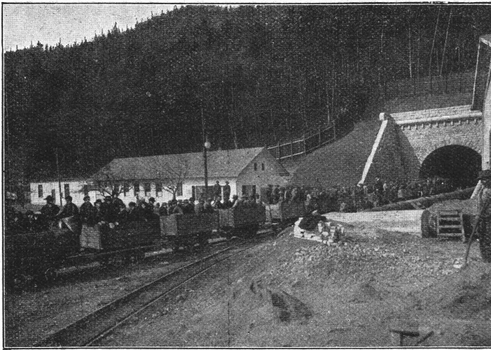
Südportal des Hauenstein-Basis-Tunnels.
