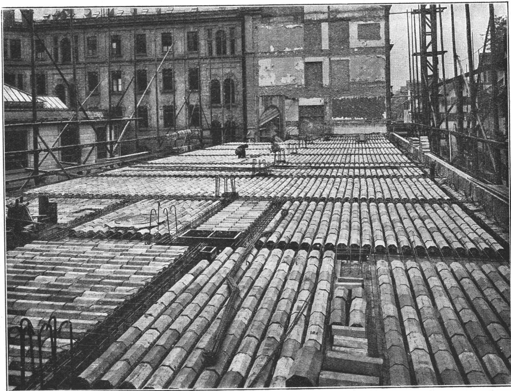
Neubau Kreditanstalt Zürich. Decke über Parterre. Ausgeführt durch: Baugeschäft Locher & Co., Zürich. Bauleitung: Gebrüder Pfister, Architekten, Zürich.
