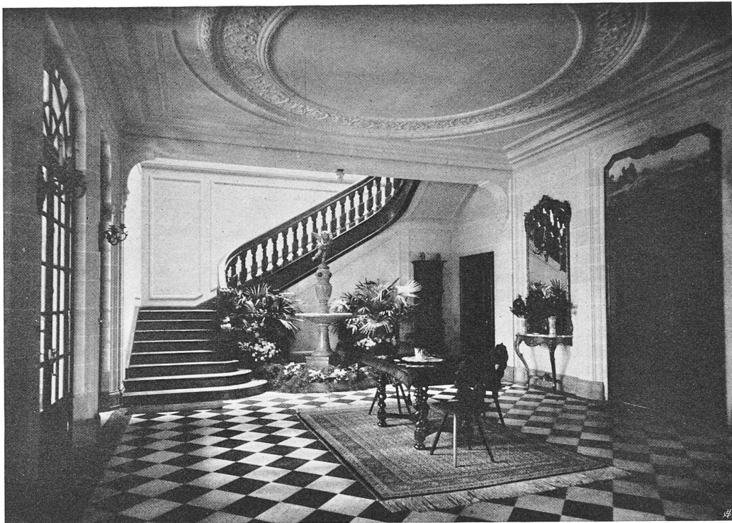
EINGANGS-VESTIBULE UND TREPPENHAUS
