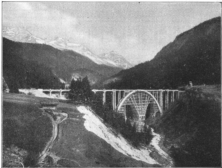
Eisenbahn-Viadukt bei Langwies an der Linie Chur-Arosa, Gesamtlänge 286 m, Bauzeit 1913-1914.
