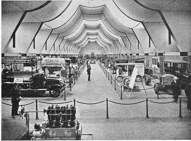
Abb. 6. Mittelhalle der Gruppe „Ingenieurwesen“. Arch. Zeerleder & Bösiger, Bern.
