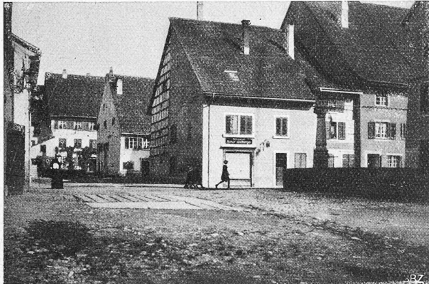
Abb. 13. Westliche Querstrasse im schaffhausischen Neunkirch.
