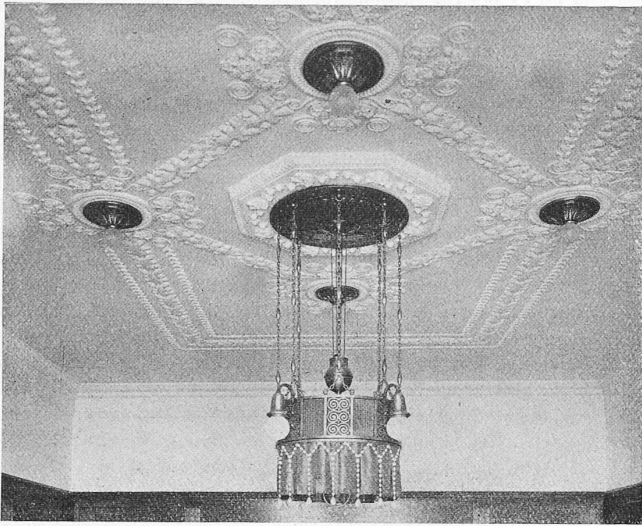
Abb. 12. Villa in Wollishofen; Decke im Speisezimmer.
