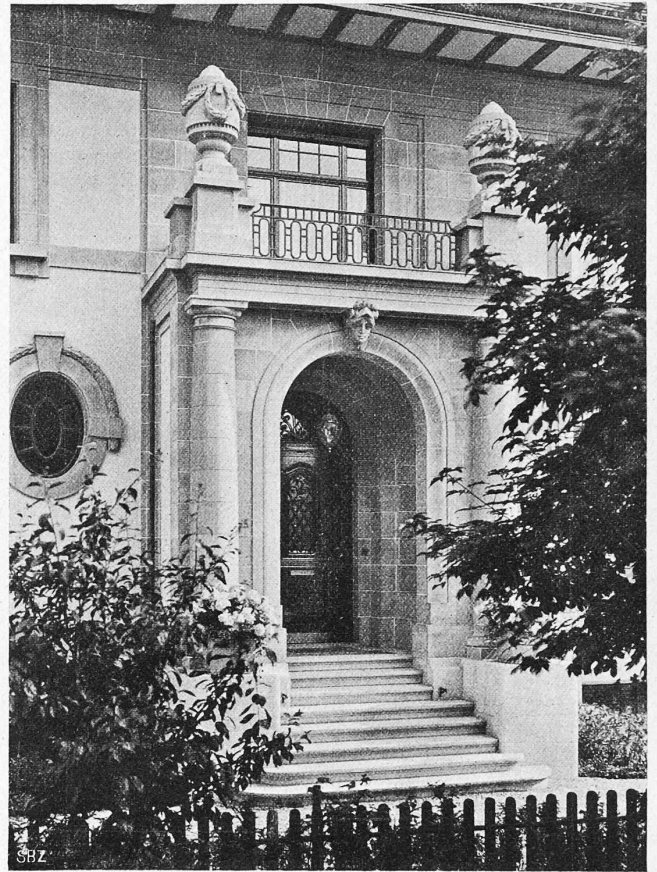
Abb. 6. Ansicht des Haupteinganges.
