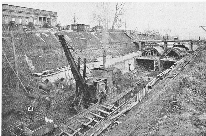
Abb. 41. Bagger kehrt auf Einschnittssole zurück; Gewölbe-Betonierung, Schnitt g-g (25. XI. 12).
