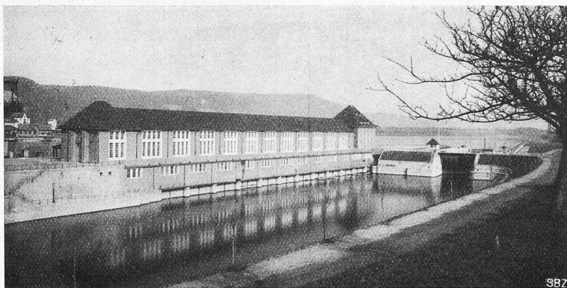
Abb. 21. Ablaufkanal von Süden, mit Zentrale und Schleusen-Unterhaupt.
