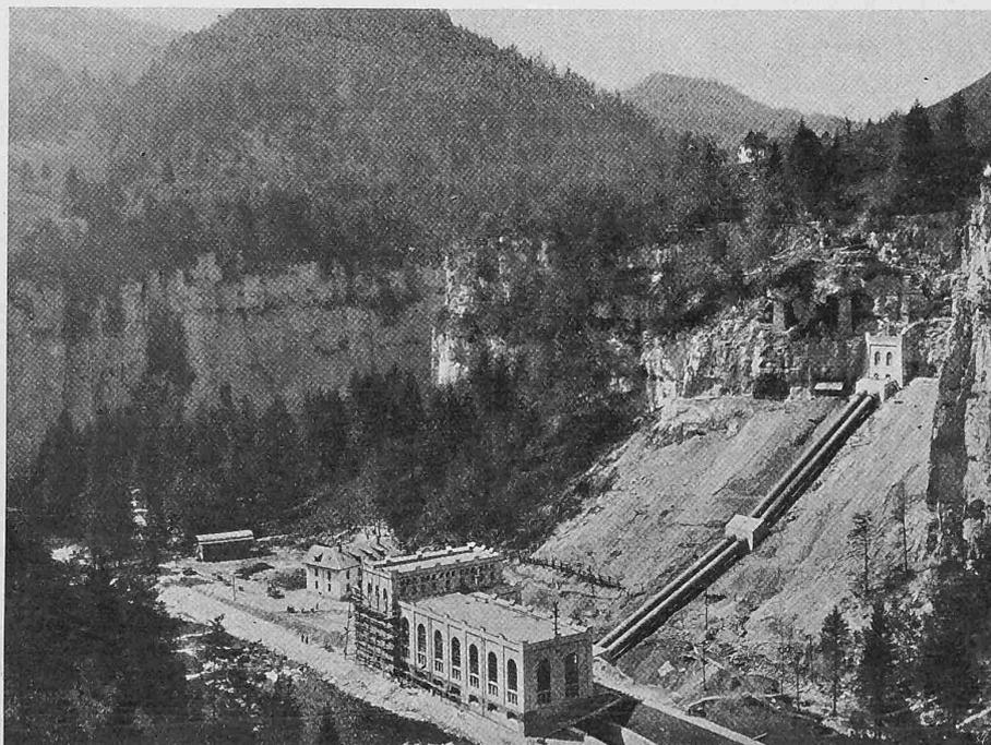
Abb. 15. Schieberhaus, Druckleitung und Zentrale Refrain am Doubs.
