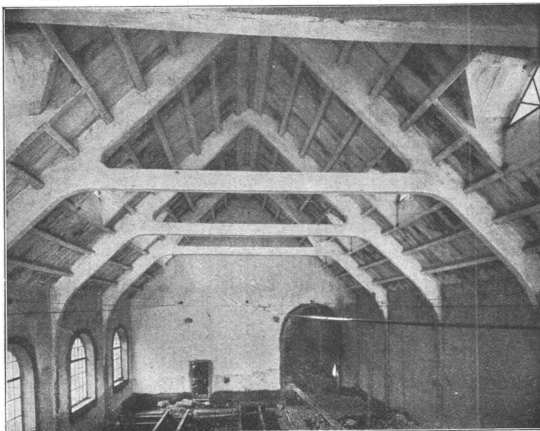
Remise der Chur-Arosa-Bahn in Chur. — Dachkonstruktion in Beton.
