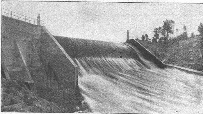
Selbsttätiges Ueberfallwehr Osfaldet für Aamot kommunale Elektricitetsverk (Norwegen)
