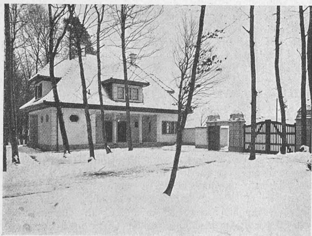
Abb. 3. Friedhofgärtner-Wohnhaus beim Eingang.
