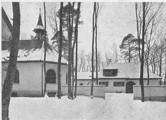
Abb. 8. Blick gegen West, Leichenwärter-Wohnhaus.
