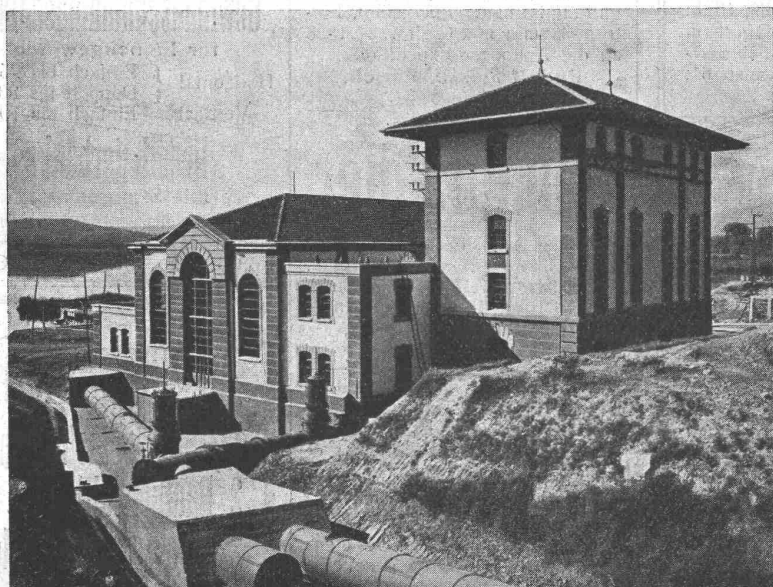
Hydraulische Akkumulierungsanlage Viverone (Italien). Maschinenhaus am Viverone See.
