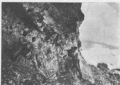
Abb. 6 und 7. Mechanische Bohrung am Felsvorsprung der „Nase“.
