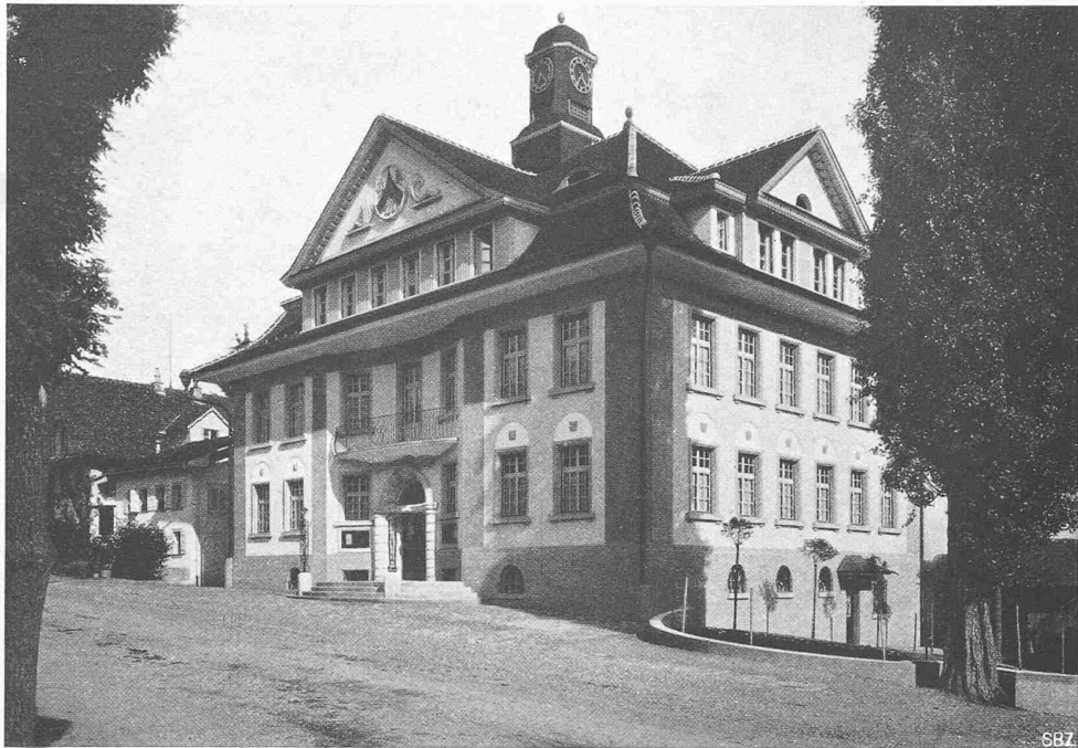
HAUPTANSICHT UND STRASSENBIELD
