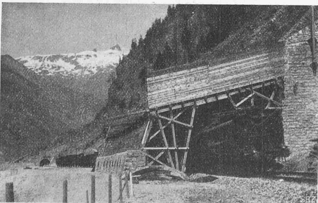
Abb. 34. Prov. Holzgalerie im Stockgraben-Lawinzug.
