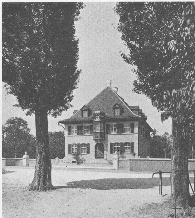
Abb. 5. Ansicht aus Nordost.
