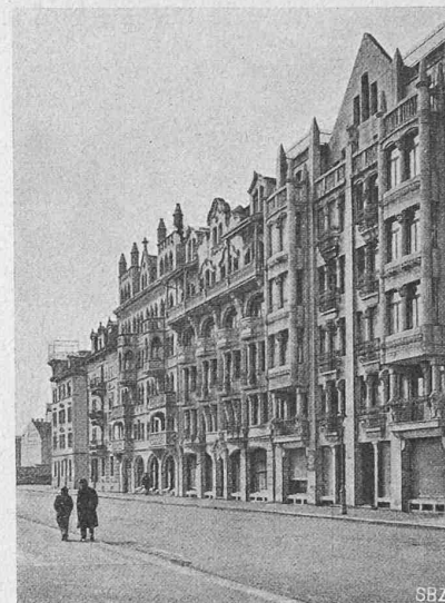
Abb. 10. Sihlfeldstrasse in Aussersihl.
