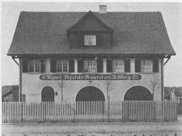
Abb. 18. Brauerei-Niederlage in Altstetten bei Zürich.
