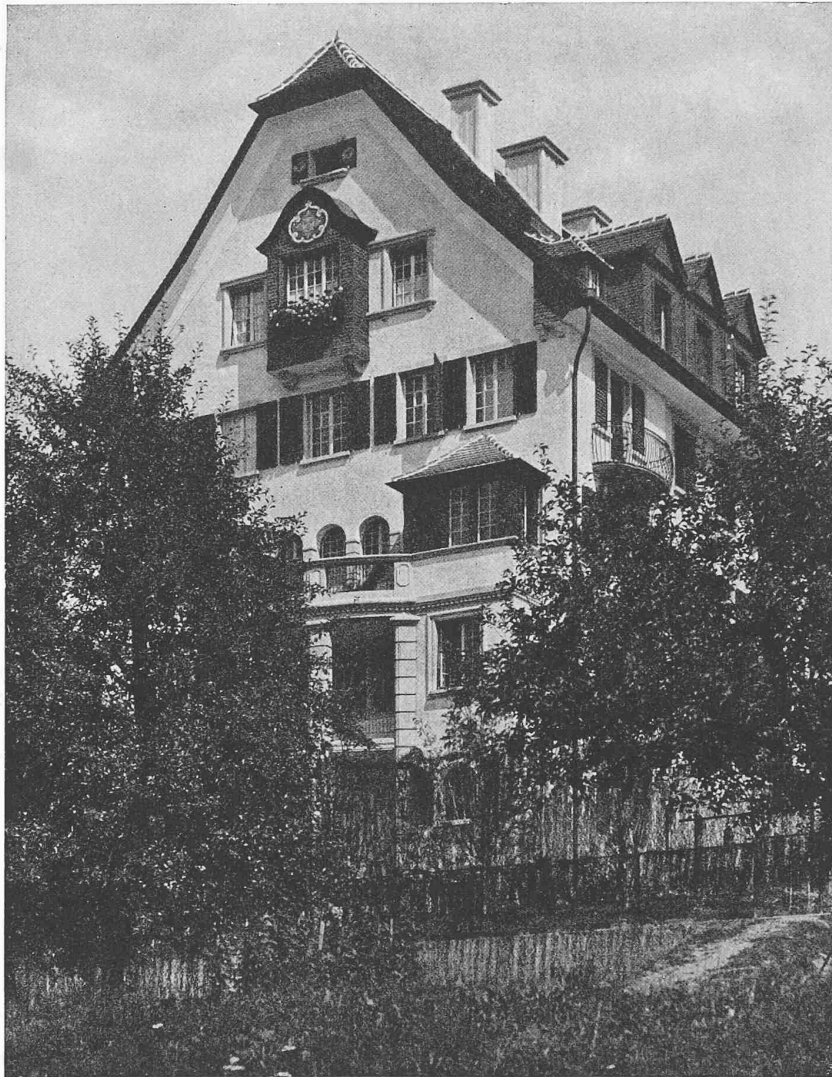
MEHRFAMILIEN-WOHNHAUS AN DER TITLISSTRASSE IN ZÜRICH
