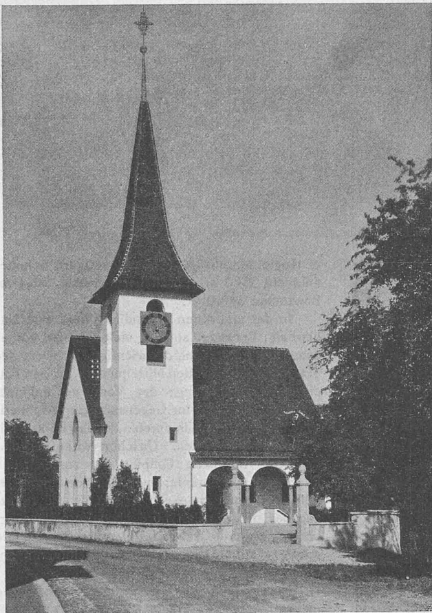
Abb. 4. Ansicht von Süden.
