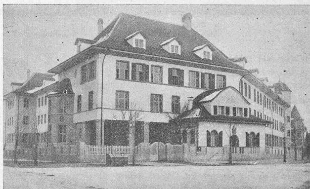
Abb. 11. Haupteingang und Abwartwohnung (im kleinen Anbau), Ecke Pestalozzi- und Weissenstein-Strasse (vergl. Grundriss Abb. 10).
