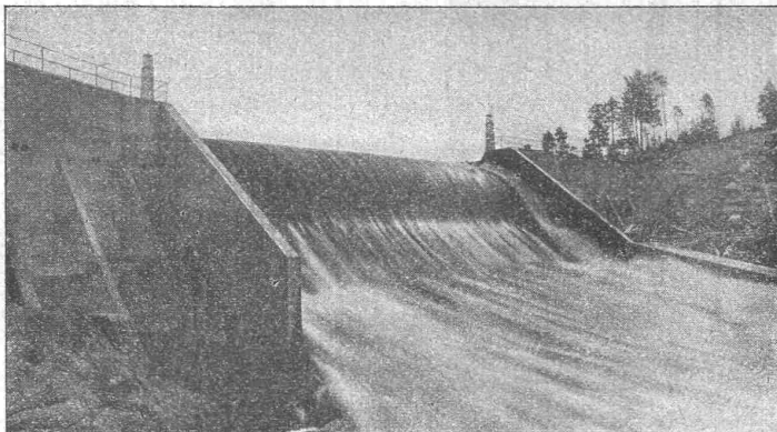
Selbsttätiges Ueberfallwehr Osfaldet für Aamot kommunale Elektrizitätsverk (Norwegen)
