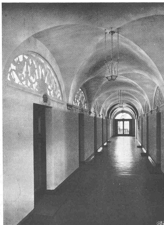
TREPPENHALLE UND KORRIDOR IM I. STOCK
