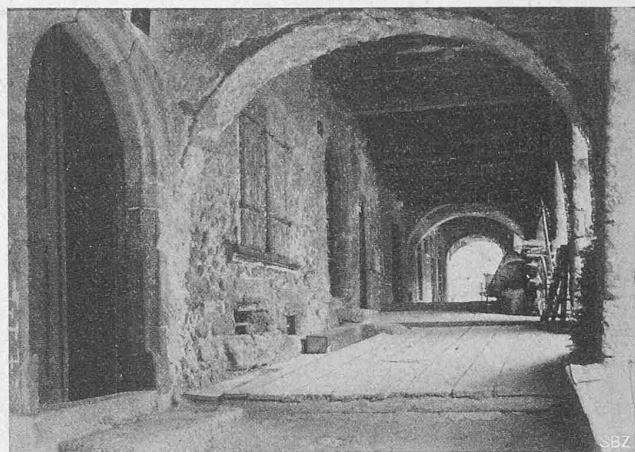
Abb. 10. Laubengang der Häuser Nr. 17 bis Nr. 5.
