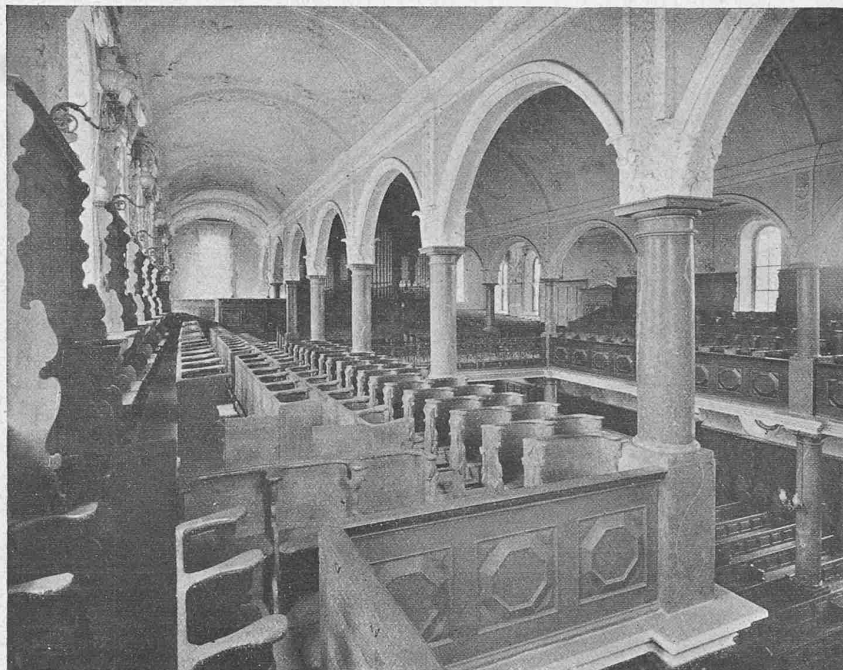
Abb. 3. Innenansicht vor der Renovation, gegen die alte Orgel.
