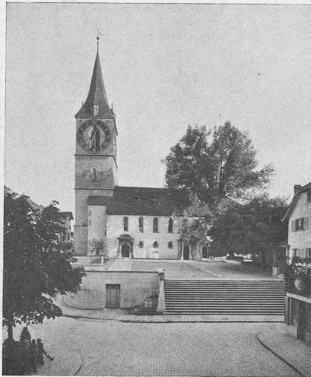
Abb. 1. Peterskirche und Peterhofstatt, nach der Renovation, von Norden.
