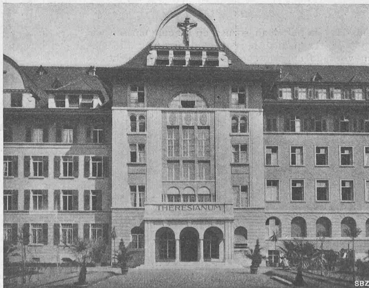
Abb. 3. Teilweise umgebauter Mittelbau mit Haupteingang. Links das Noviziat (alt), rechts das Töchterpensionat (neu).
