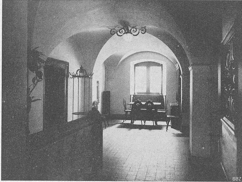
Abb. 7. Treppenhaus (Halle) im I. Stock.
