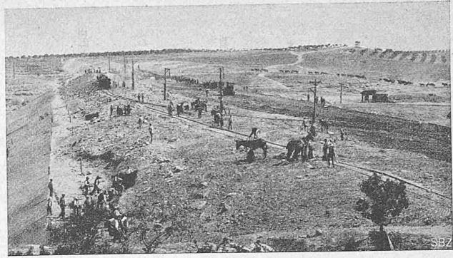
Abb. 67. Vom Bau des Damms Nr. 2. (20. Juli 1913.)
