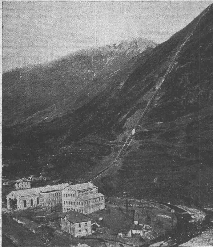
Wasserkraftanlage in den spanischen Pyrenäen. Maschinen- und Transformatorenhaus, Direktionsgebäude und Druckleitung
