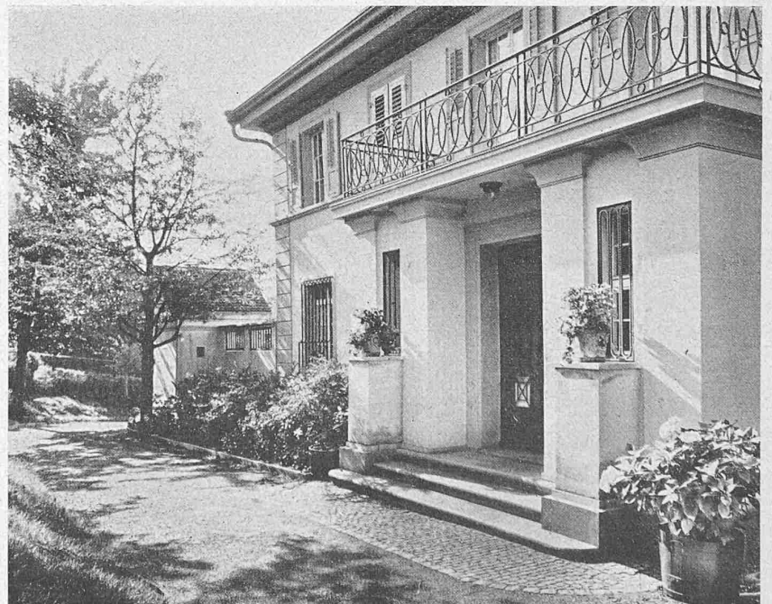
Abb. 7. Anfahrt und Hauseingang an der Rückseite.
