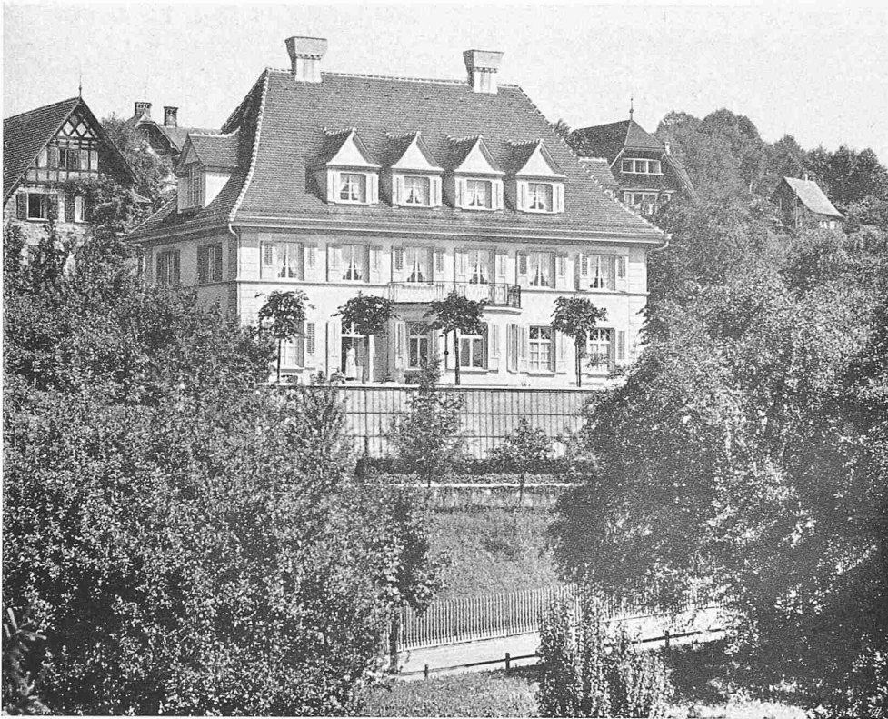
GESAMTBILD AUS SÜDWEST
