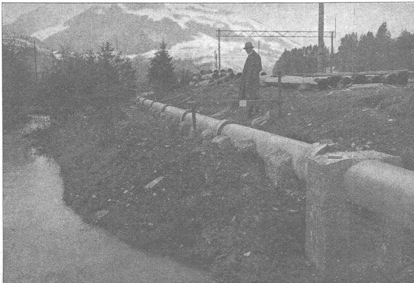
Wasserleitung der neuen Pulverfabrik in Wimmis, aus armierten Siegwart-Röhren von 400 mm Durchmesser.
