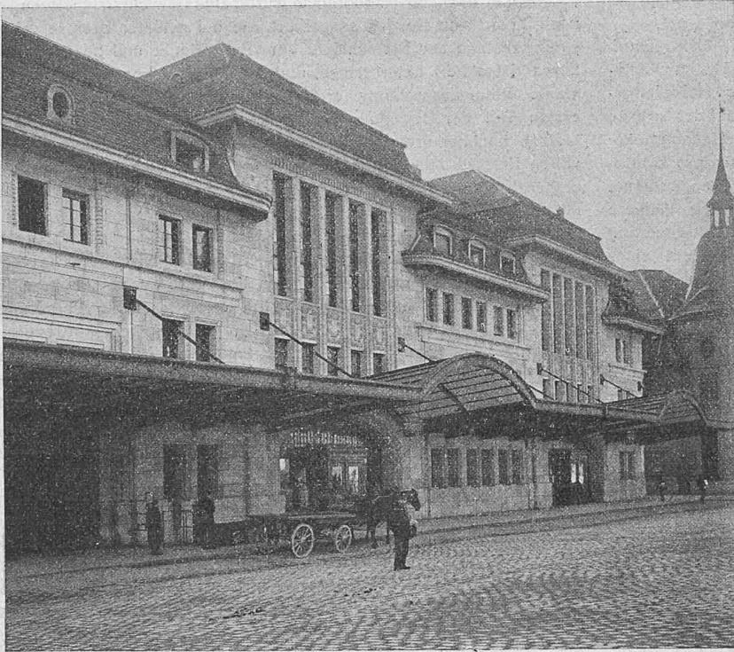
Abb. 7. Westlicher Flügel des Aufnahmegebäudes.
