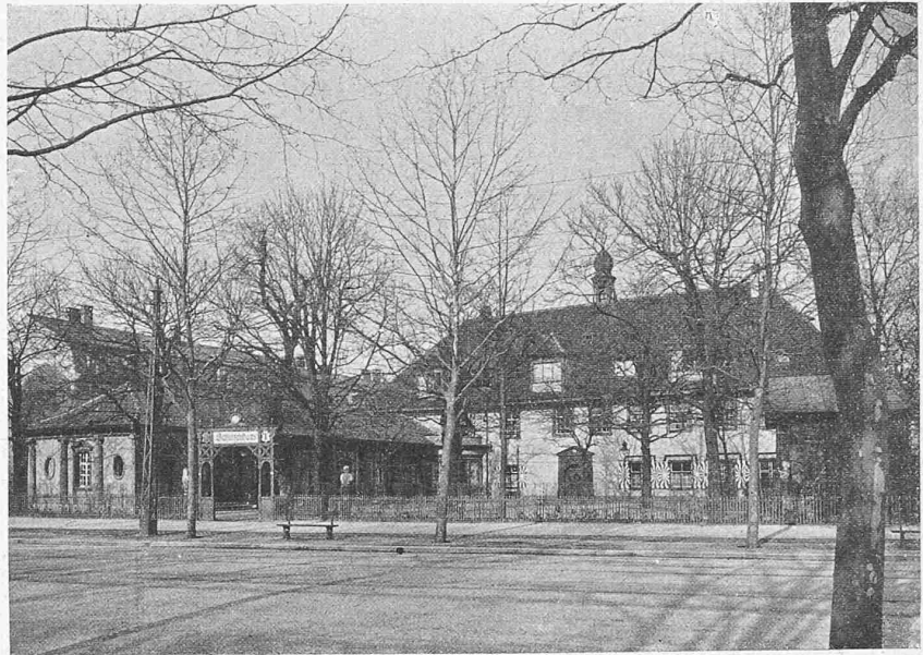
Abb. 4. Das umgebaute Schützenhaus aus SW, vom Spalenring aus.
