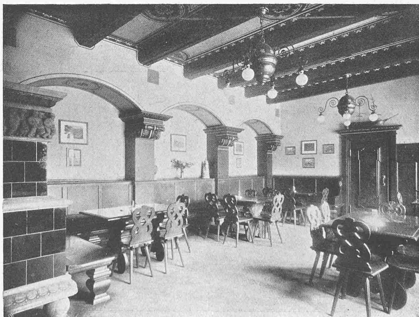
UMBAU DES ALTEN SCHÜTZENHAUSES IN BASEL
