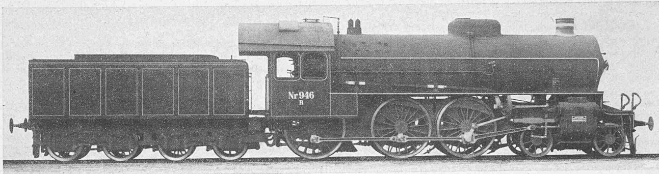
Abb. 2. \frac{3}{4} gekuppelte Heissdampf-Schnellzuglokomotive, Klasse F, der Dänischen Staatsbahn.
