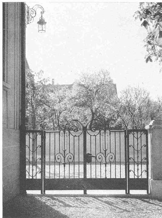
WOHLFAHRTSHAUS DER VEREINIGTEN DRAHTWERKE A.-G. BIEL
