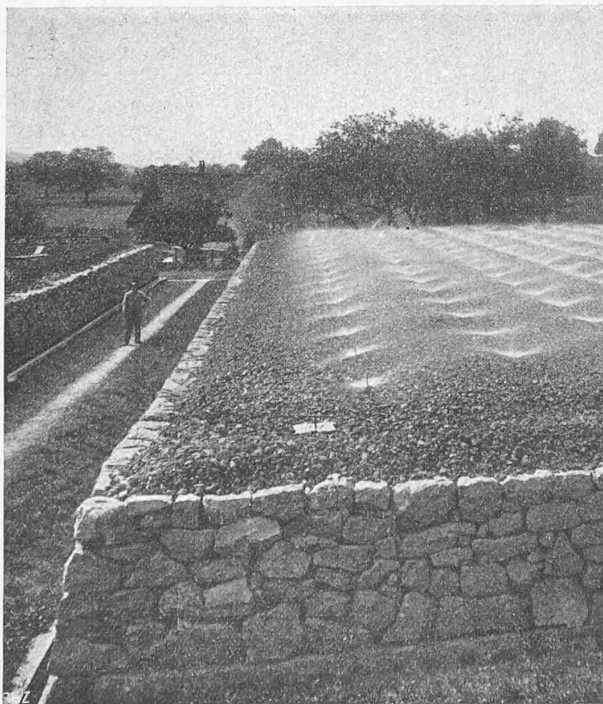
Abb. 16. Ansicht der Tropfkörper im Betrieb.
