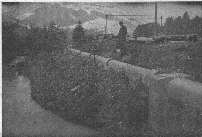
Wasserleitung der neuen Pulverfabrik in Wimmis, aus armierten Siegart-Röhren von 400 mm Durchmesser.
