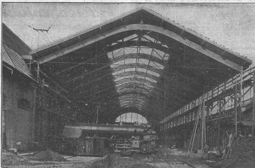
Montagehalle der Schweiz. Lokomotiv- und Maschinenfabrik Winterthur. Spannweite der Hetzerbinder 24 1/2 m.
