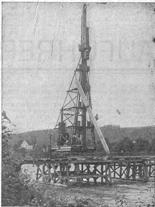
Vom Bau der Eisenbahnbrücke über die Aare bei Däniken. Rammung der Pfahljoche mit Eisenbetonpfählen (System Züblin)
