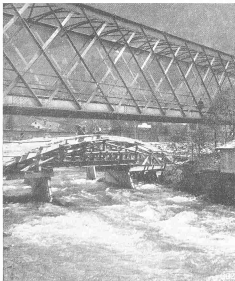
Abb. 9. Lehrgerüst bei Mittelwasser
