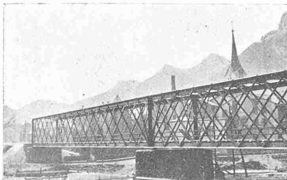
Abb. 1. Die alte Gitterbrücke.
