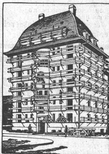
Ansicht eines eingerüsteten Hauses
